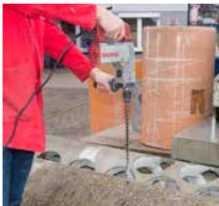
Pilotbohrung mit  $\varnothing$  20 mm
